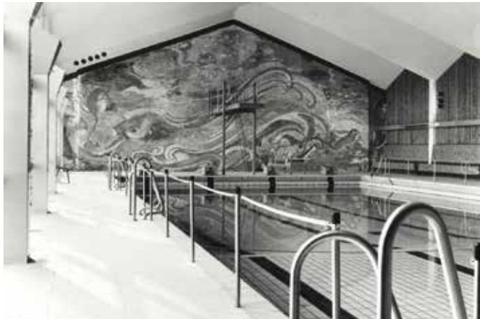
Abb. 8 Innenansicht Hallenbad (70er)
