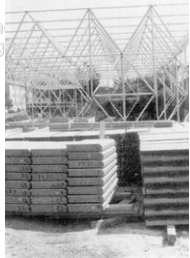
Baustillfoto vom Aufbau der Außenwände 1964 (Quelle siehe Nr. 2)
