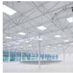
Abb. 3: Blick in das Klaus Steilmann Auditorium
