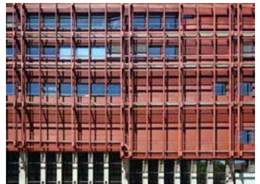
Abb. 9: Fassade zur Peter-Merian-Straße
