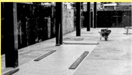
Abbildung 05: Einbringung der Folien auf der Einzeldecke.
