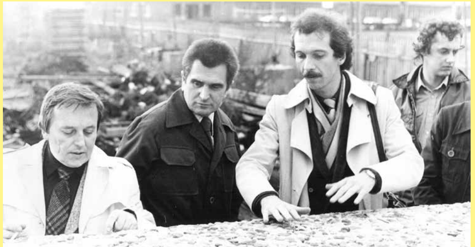
Abbildung 07: Begutachtung der Kieselbeton-Fassadenelemente durch das Planungsteam vor dem Einbau auf der Baustelle.
