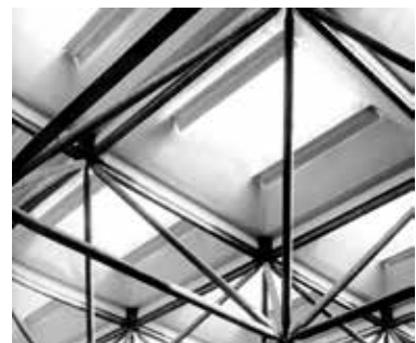
Mero System unter den Oberlichtern im Saal der Kirche (Quelle siehe Nr. 2)
