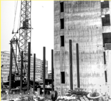
Abbildung 03: Montage der Stahlstützen um den Gleitkern.
