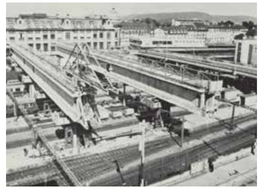
Abb. 7: Taktschiebeträger im Herstellungsprozess
