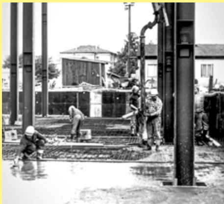
Abbildung 04: Betonage und Abziehen der Decken.
