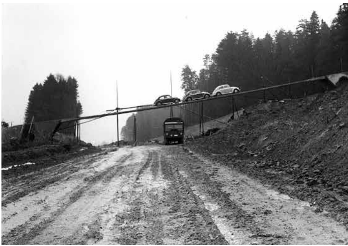
Abb. 2: Statische und dynamische Messungen, 1966
