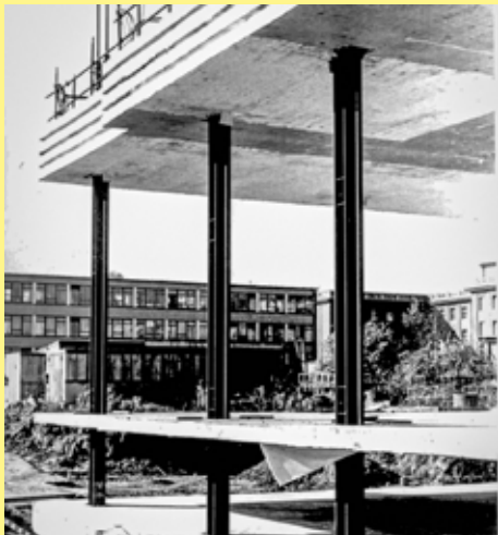
Abbildung 06: Anheben und Fixierung der Decken.
