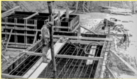
Abbildung 02: Herstellung der Fundamente.
