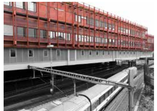
Abb. 10: Südseite des Postreiters über den Gleisen
