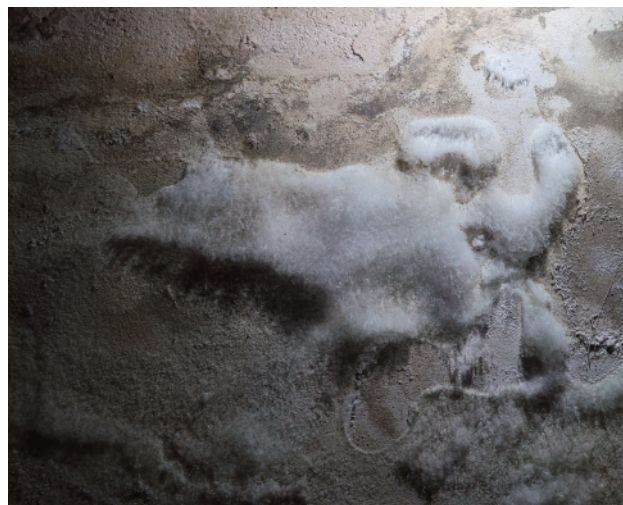
Abb. 1: Salzkristallisation an Wandmalerei birgt großes Schadenspotenzial
