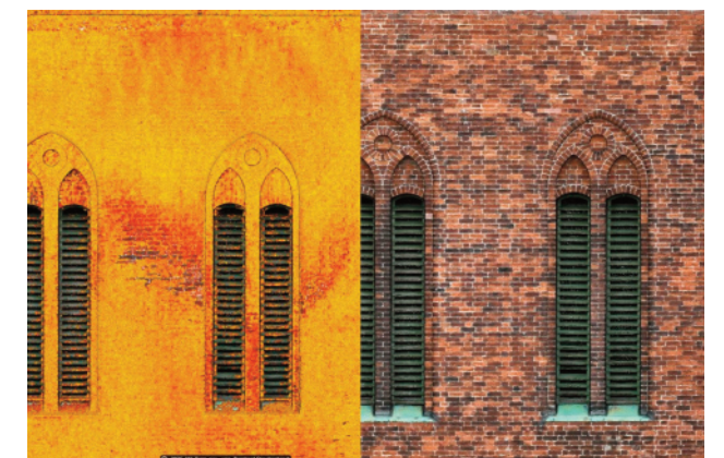
Abb. 4: Abweichungen im Bereich des Glockenstuhls bis 6 mm in Rottönen
