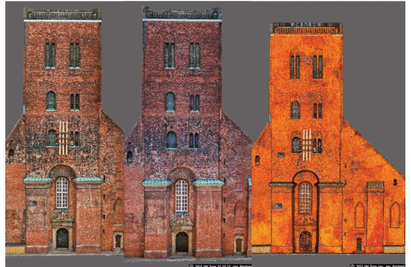
Abb. 3: 3D-Punktwolken von 2023 und 2025 sowie Soll-Ist-Vergleich
