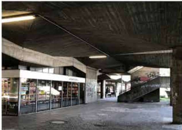
ABB. 03 Unterhalb der Lesesäle, gefaltete Decke
