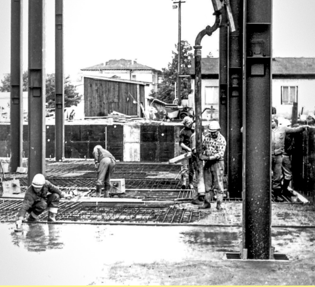
Abbildung 04: Betonage und Abziehen der Decken.
