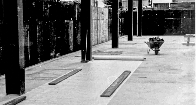
Abbildung 05: Einbringung der Folien auf der Einzeldecke.
