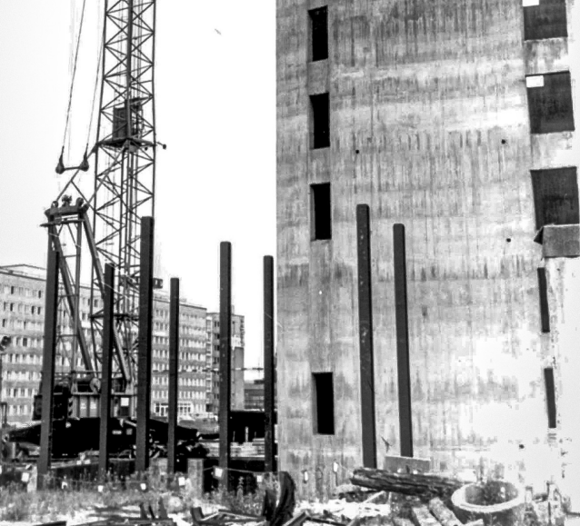
Abbildung 03: Montage der Stahlstützen um den Gleitkern.
