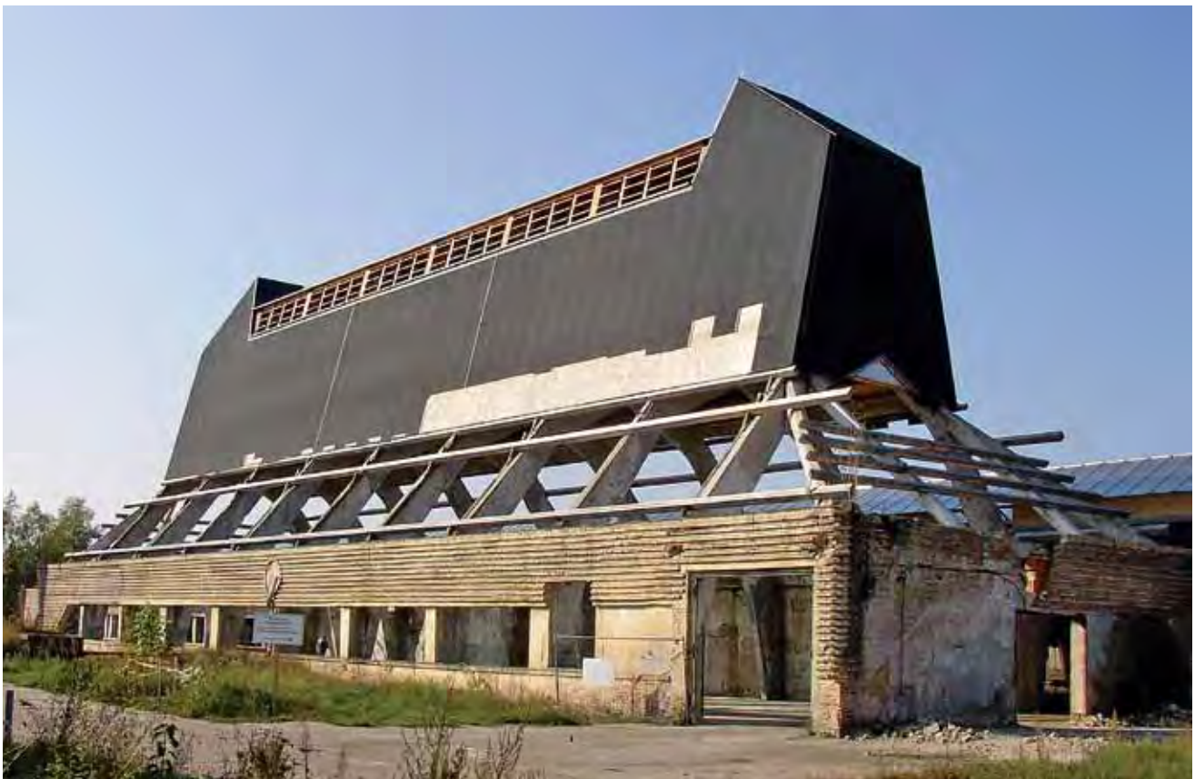
Hutfabrik Luckenwalde, Färbereihalle mit dem hutförmigen Lüftungsaufsatz nach der Wiederaufrichtung der Dachkonstruktion, um 2007.
