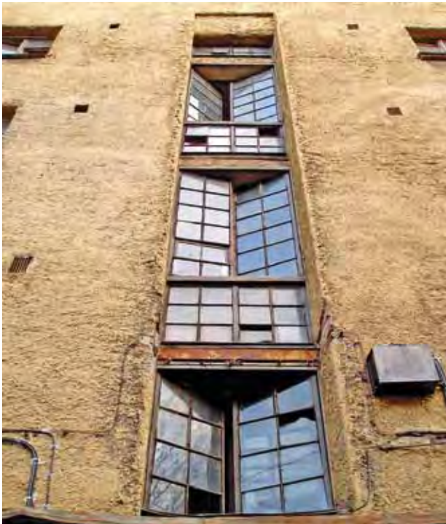
Кондратьевский жилмассив. Фрагмент сохранившегося оригинального остекления лестничного пролёта (Л. М. Тверской, Г. А. Симонов, И. Г. Капцуг, Т. Д. Каценеленbogen, 1929–1931). Фото 2007.
